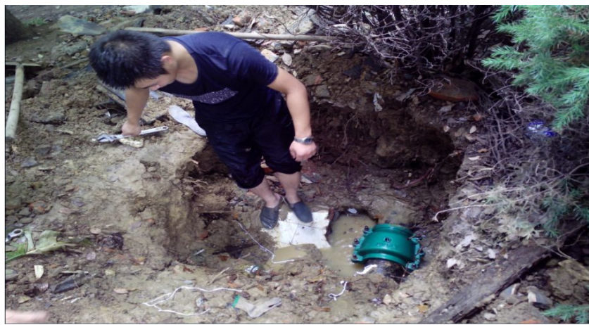
现场修复后照片
