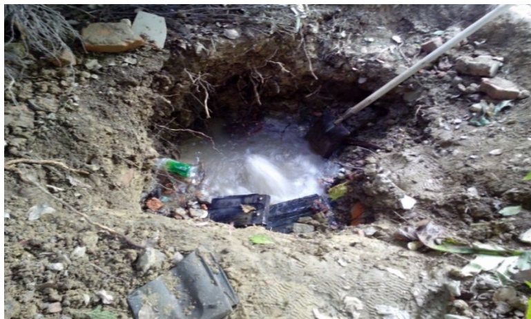
现场渗漏点照片
