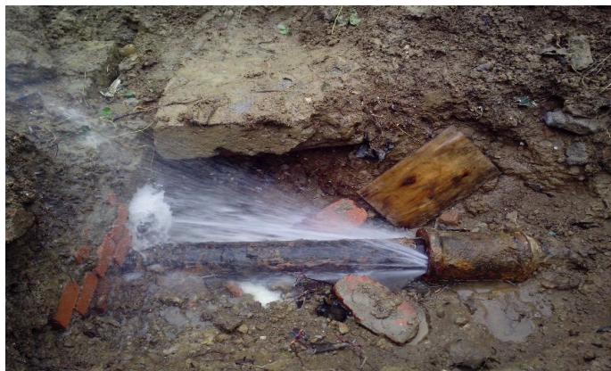
现场渗漏点照片
