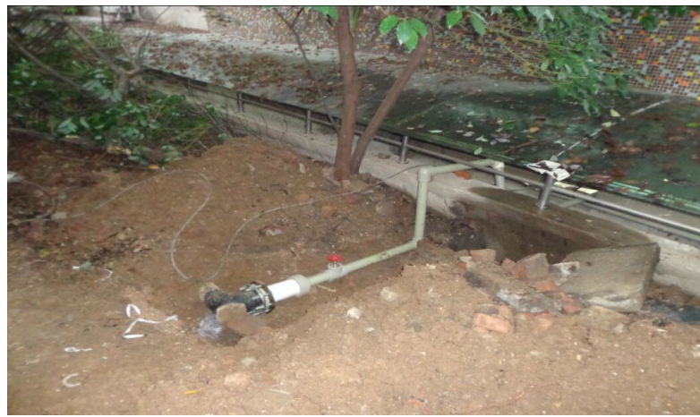
现场修复后照片
