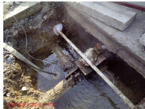
排查出的漏水点
